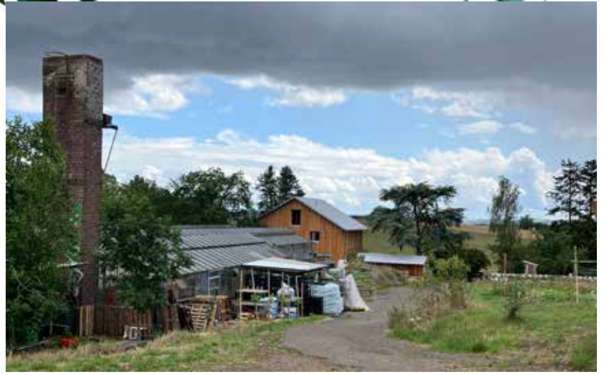
Ein Blick über das Gelände der Gärtnerei mit dem prägenden Heizturm der heute aber stillgelegt ist.
