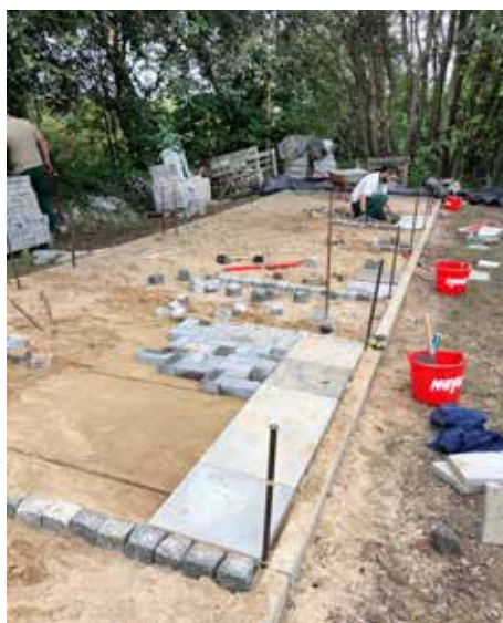
Seminar Pflasterarbeiten auf der Baustelle der Bildungsstätte in Grünberg
