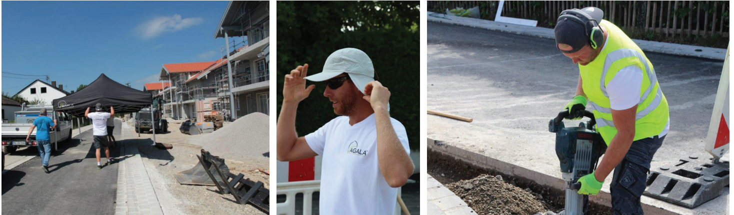
Sonnenschutzpavillons, Funktionsshirts, Kopfbedeckungen sowie Kühlfunktionskleidung schützen vor UV-Strahlung und Hitze während der Arbeit.
