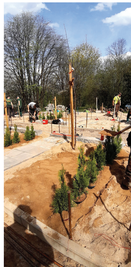
Frisch am Werk auf der Übungsbaustelle
